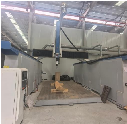
大型雕刻加工区 (未设置集气装置和房闭车间)
