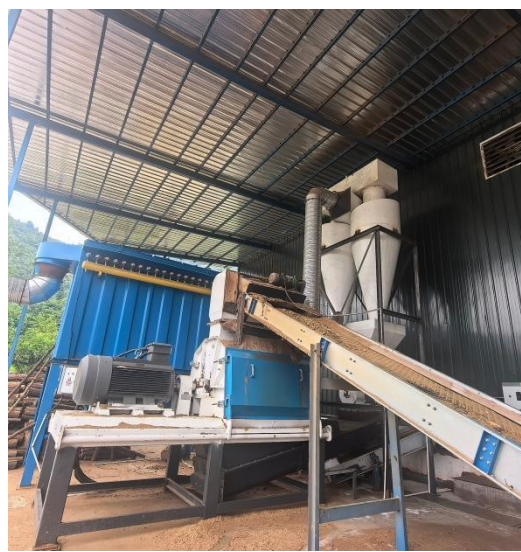
破碎机，输送带（未封闭）
