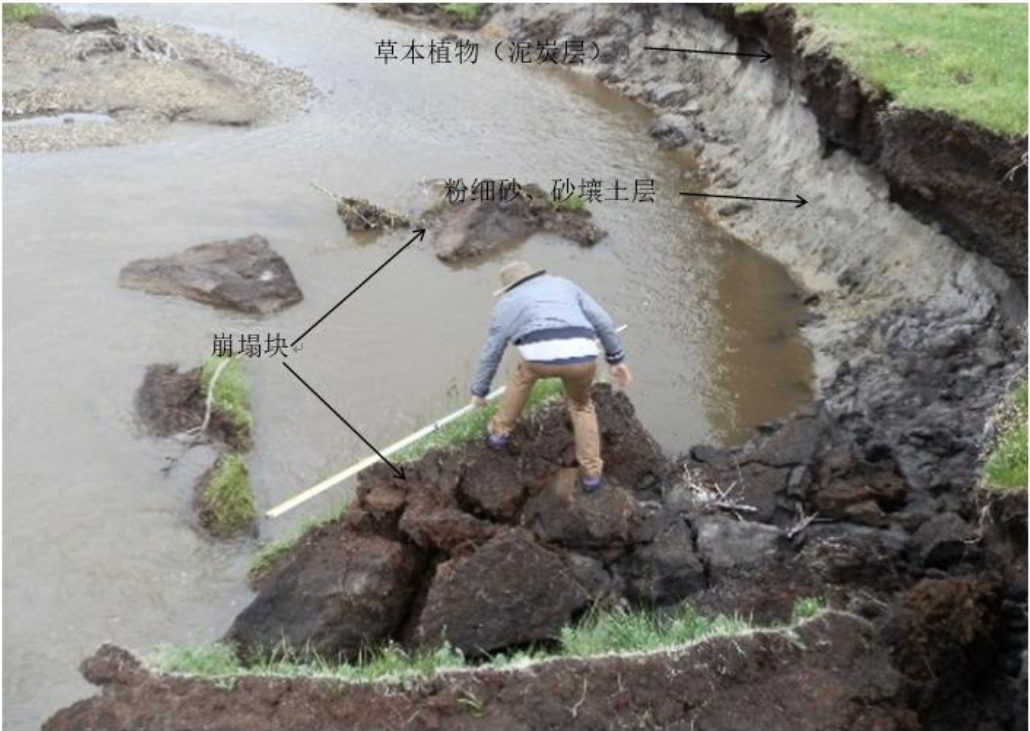
图 3-4 河岸崩塌分析照片
