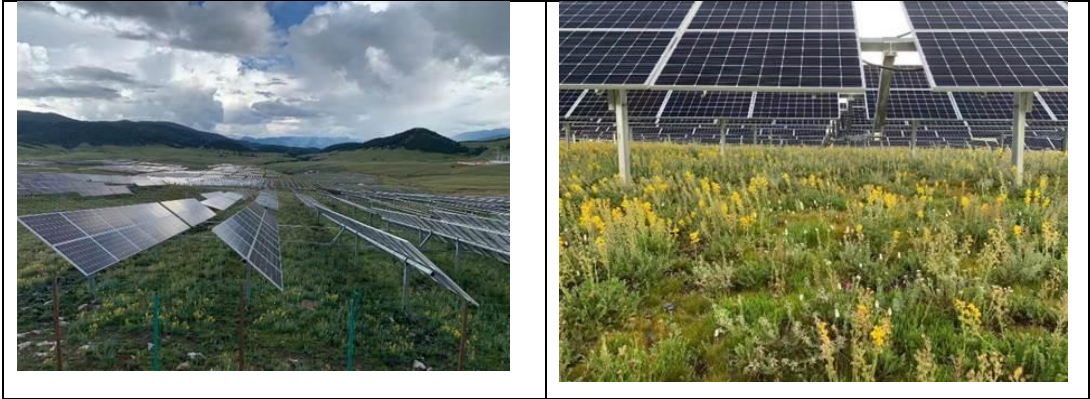
图 4-4 正斗 50MW 光伏电站光伏场区植被恢复情况
