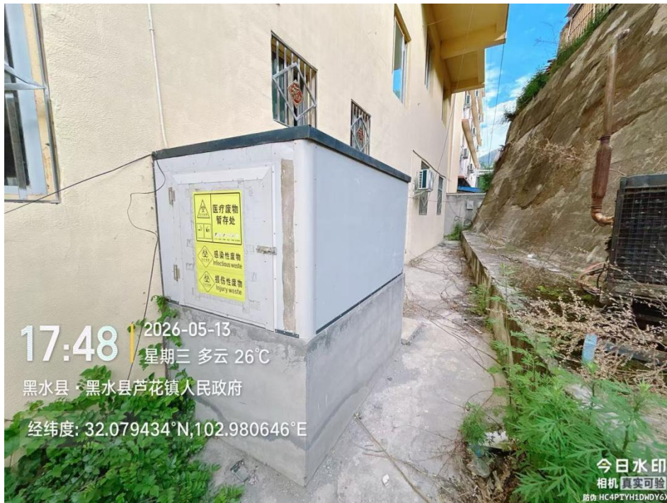
图 2-12 现有医废暂存间
